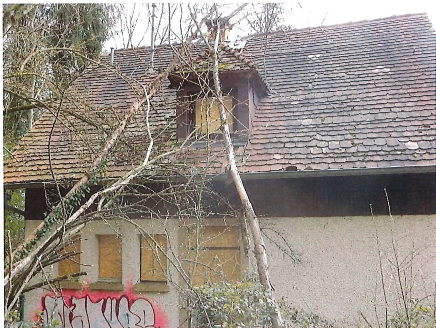
Foto 2: Kleineres Wohngebäude im Norden des Pla- nungsgebietes (eigene Aufnahme, April 2020)
