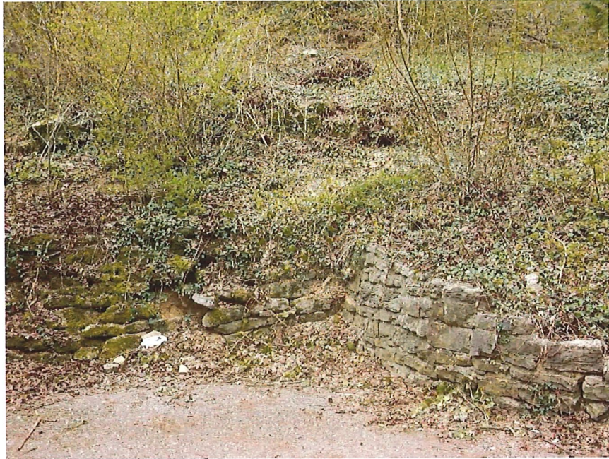
Foto 3: Bewachsene Mauer im Süden des Planungsge- bietes (eigene Aufnahme, April 2020)
